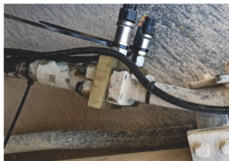
软管上部接口安装传感器
